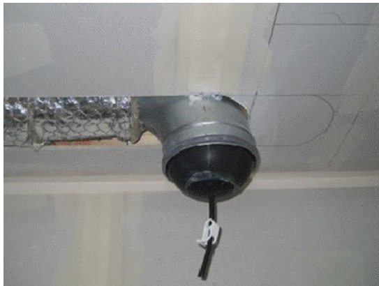
Figur 23 Tätning Im-kanal och VP-rör
