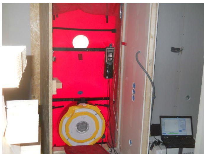
Figur 21 Blowerdoor monterad i huvudentré vänster hus
