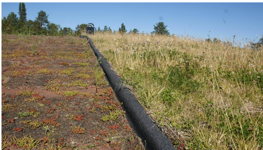
Figur 4 Sedumtak och sedum-örttak (Bild: Godecke Blecken, LTU)
