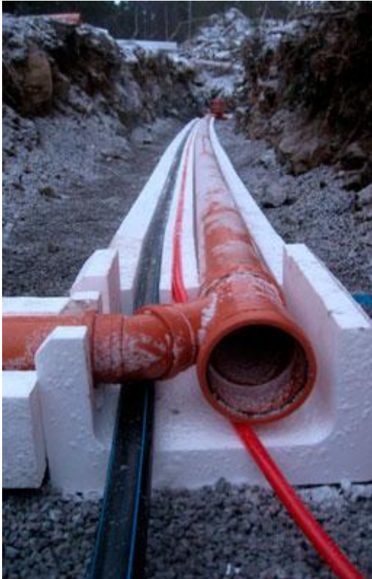
Figur 7 Samförläggning fjärrvärme med vatten och avlopp
